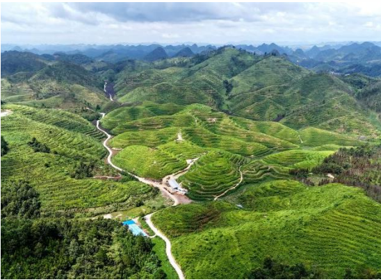
荔波县 2024 年国家水土保持重点工程
