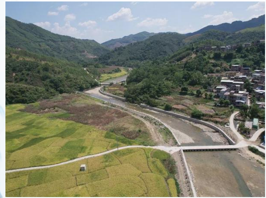
安龙县 2024 年国家水土保持重点工程
