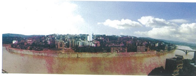
赤水市防洪堤
