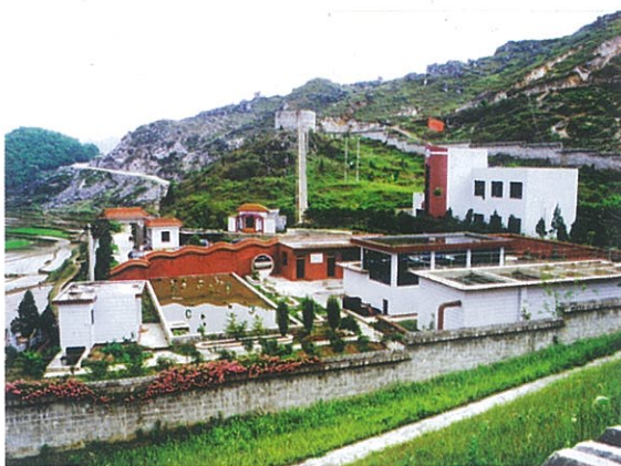
贞丰县云洞水厂全貌
