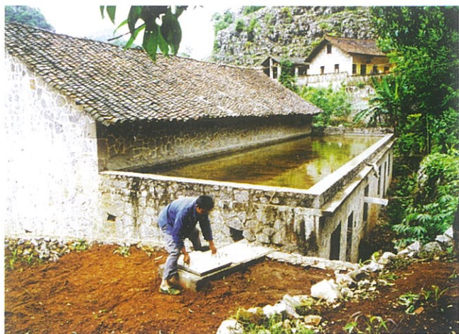
贞丰县石山区屋面集雨人饮工程
