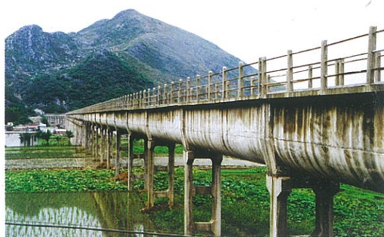
兴义市顶效农灌大渡槽
